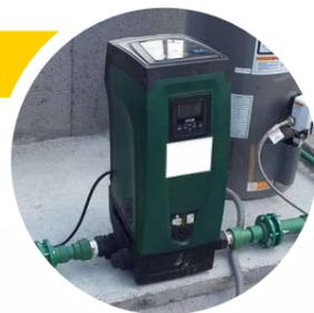
Dispositivo completo de acoplamiento para e.sybox con todas las interfaces necesarias para la conexión al sistema incluyendo los pies anti-vibración.
